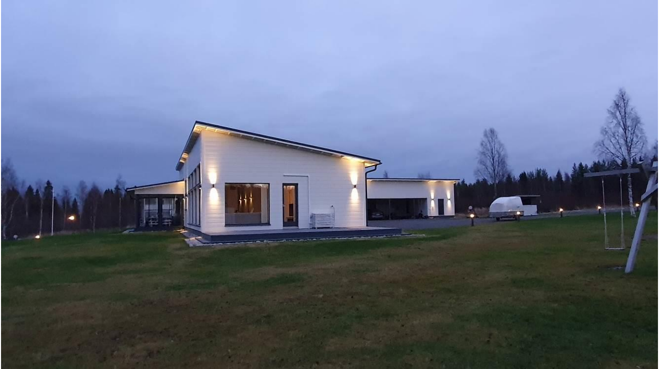
Kuva 8 Korttelin 2 rakennuspaikan 1 rakennuksia
