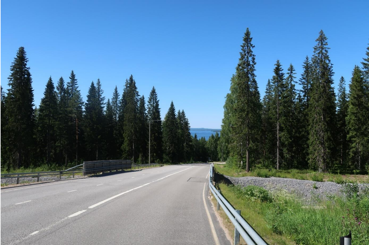
Kuva 4. Vuokatinvaaralle johtava tie latutunnelin kohdalta. Tien oikeassa laidassa rullahiihtoa varten tehty levennetyt piennarit.
