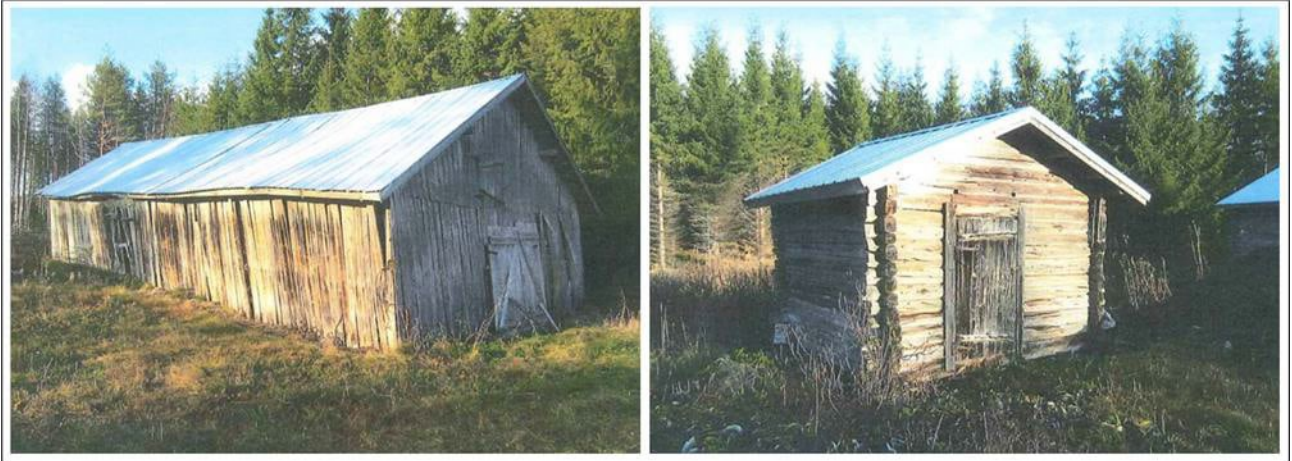
Kuva 22. Lanteen kiinteistöllä sijaitsevia vanhoja rakennuksia (Elementis Minerals).
