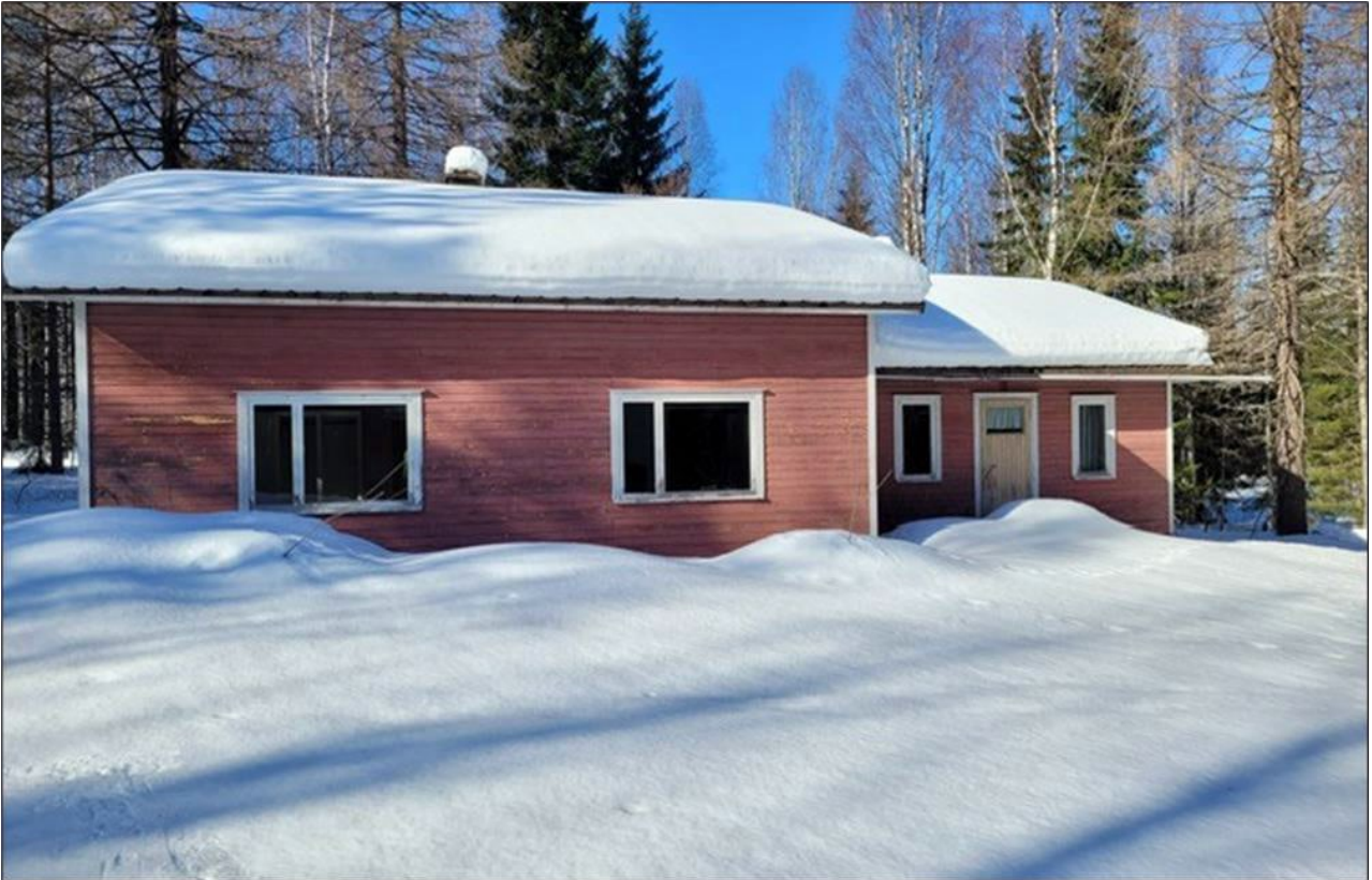
Kuva 24. Timolan vanha asuinrakennus (Elementis Minerals 2024).
