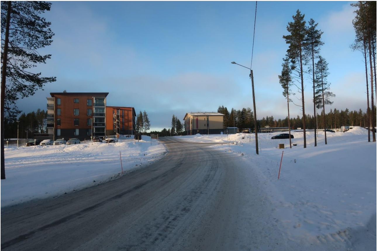
Kuva 4. Kevyen liikenteen väylä päättyy Kuurakadun risteykseen. Sitä on tarkoitus jatkaa vuoden 2024 aikana Kuurakadun risteykseen saakka.
