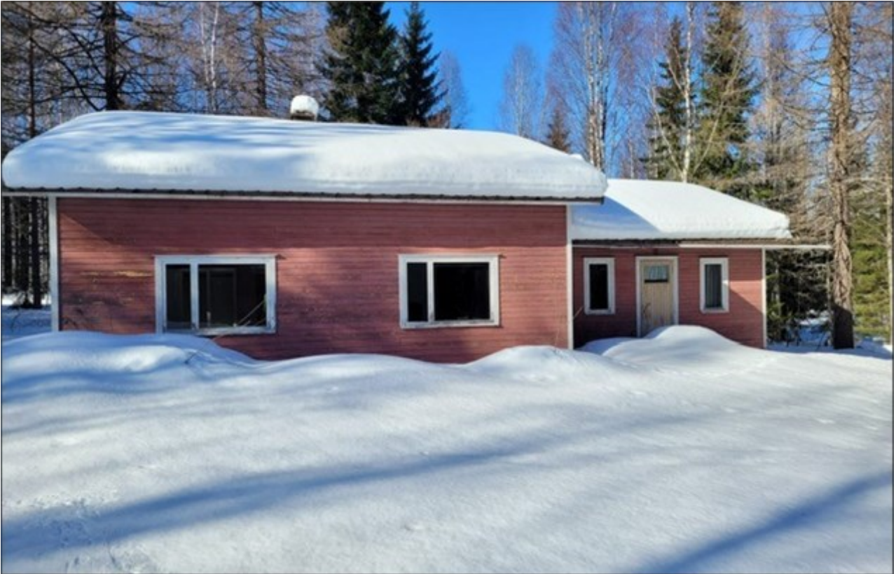
Kuva 24. Timolan vanha asuinrakennus (Elementis Minerals 2024).
