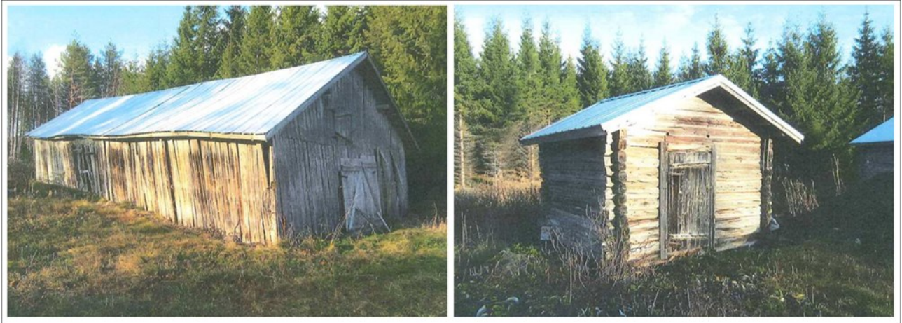
Kuva 22. Lanteen kiinteistöllä sijaitsevia vanhoja rakennuksia (Elementis Minerals).
