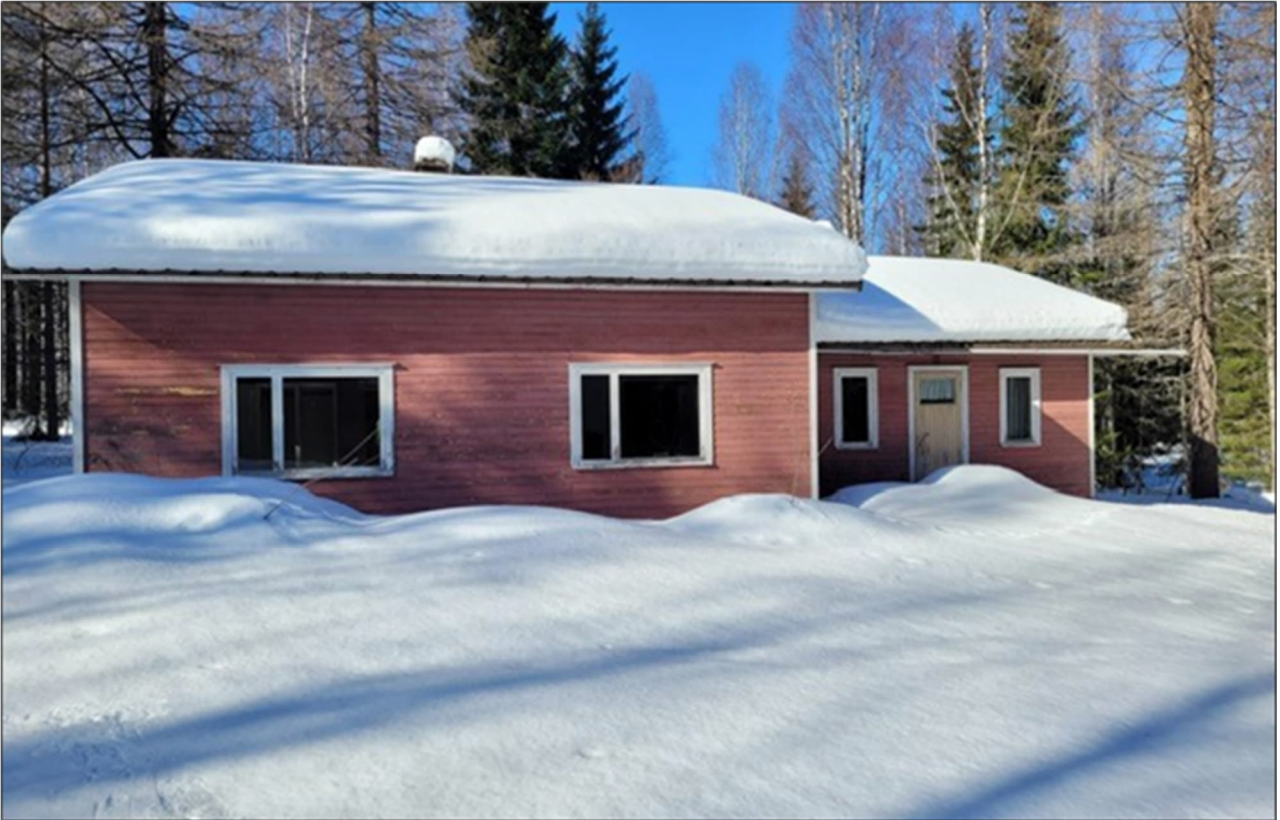
Kuva 24. Timolan vanha asuinrakennus (Elementis Minerals 2024).
