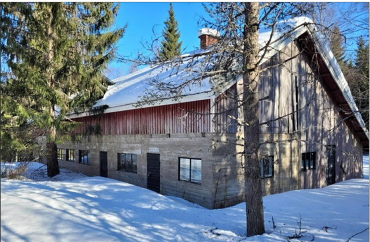
Kuva 25. Timolan kiinteistöllä sijaitseva vanha navettarakennus (Elementis Minerals 2024).
